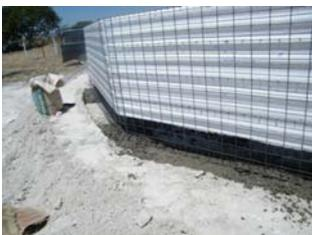
Vaciado de concreto en cepa, para anclaje de muretes.
