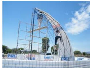
Montaje de hojas triangulares de panel, para cubierta de domo.
