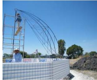
Colocación de cercha de apoyo, para montaje de paneles de cubierta.
