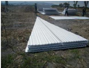
Triángulos de panel, preparados para formar la cubierta del domo.
