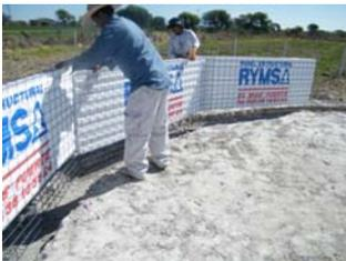
Excavación en base de desplante y colocación de muretes de panel.
