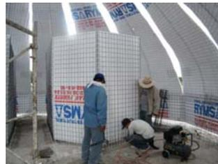
Montaje de muros de panel en el interior del domo.
