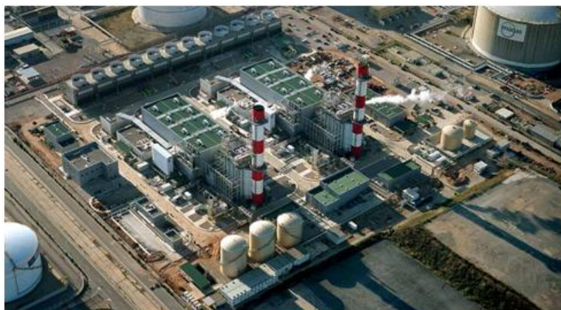
Figura 1. Fotografía de la instalación durante la fase final
