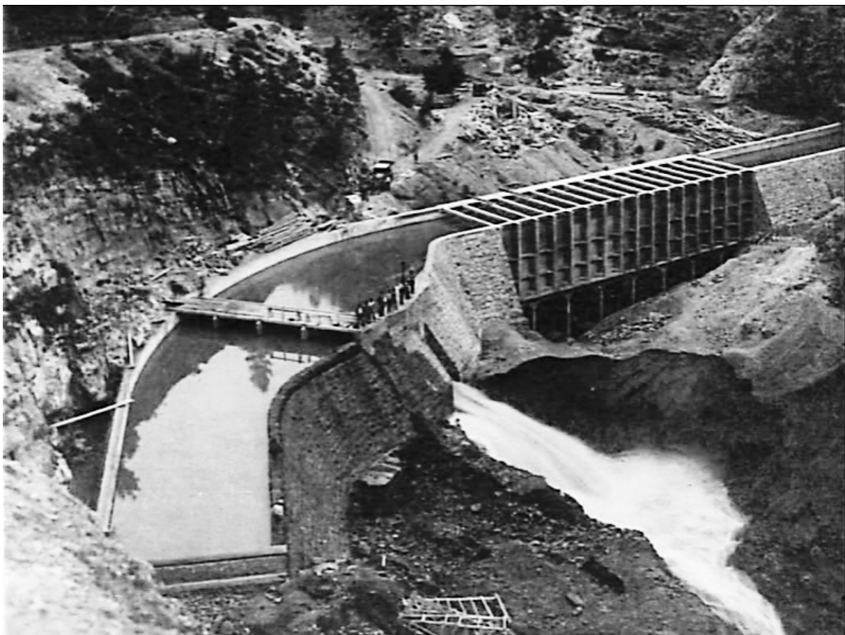
Figura 2. La construcción del Salto de Millares - Construcción de la rejilla, año 1932. Fuente: Iberdrola.
