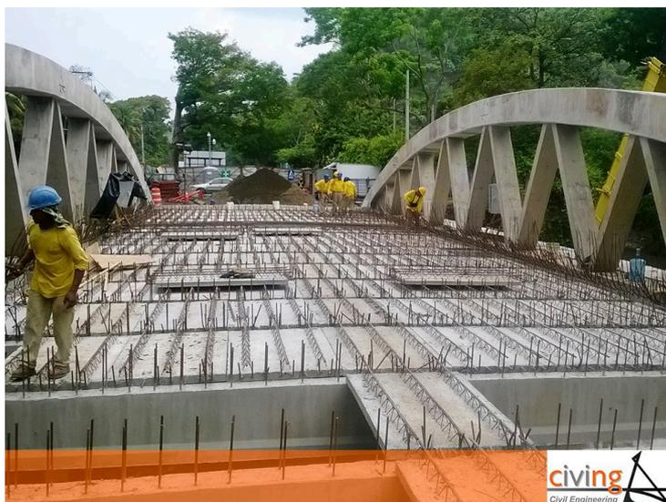
Para los estribos se optó por una estructura a base de pantallas de hormigón reforzado de 40cm. de espesor (figura 5).
