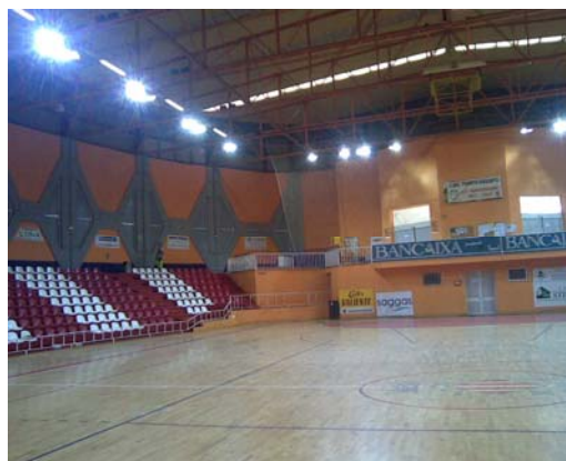
Figura 3: Interior Pabellón Polideportivo. Estado final. Fuente: Elaboración propia.
