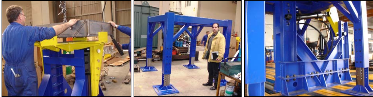
Figura 11: Detalles de montaje y terminación de soportes de la bancada
