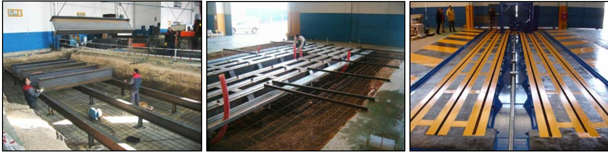
Figura 6: Detalles de ejecución de la obra correspondiente a la bancada
