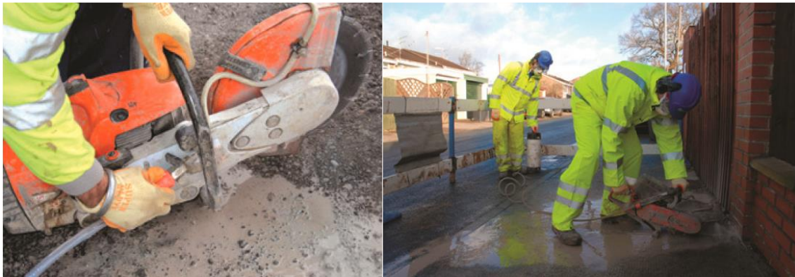
Figura 3: Punto de toma de sistema de extracción para una amoladora. Fuente: HSE
