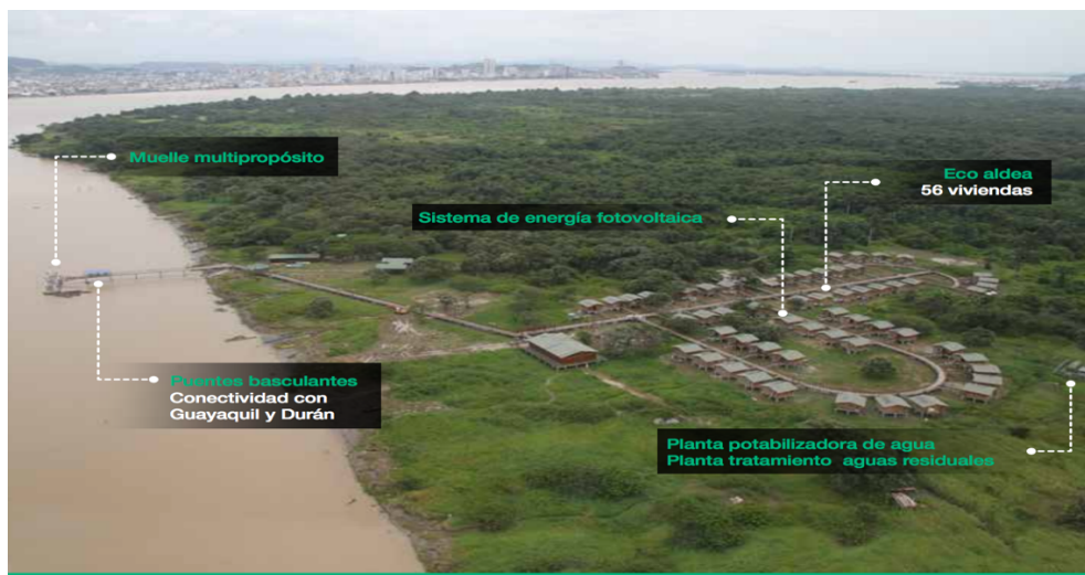
Figura 2: Proyecto ejecutado en Isla Santay.
