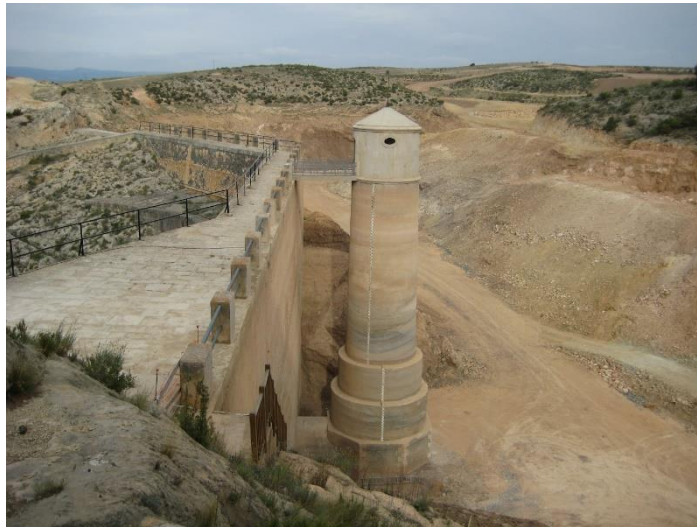
Figura 7. Imagen del embalse de Almansa dragado. En contraposición con Figura 1.
