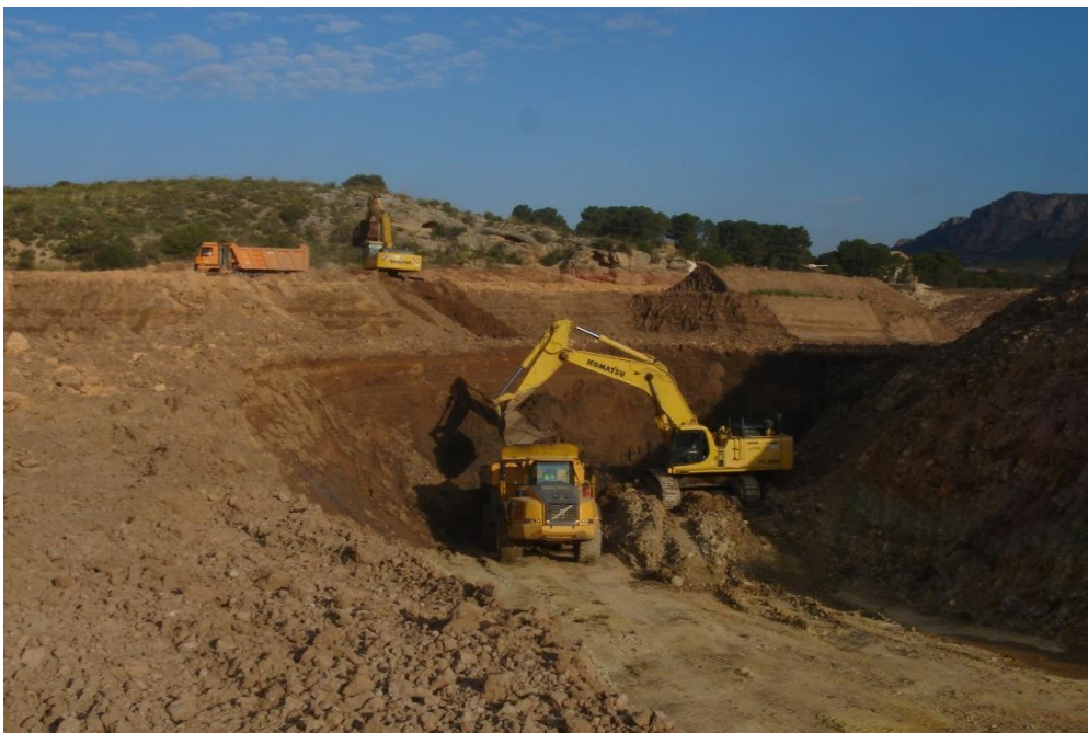
Figura 4 Maquinaria pesada en el dragado del embalse de Almansa.
