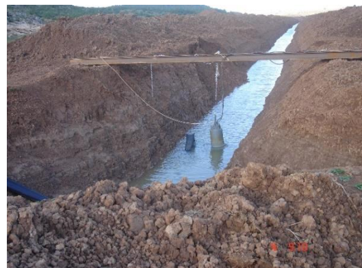
(b) Imagen del drenaje ejecutado
