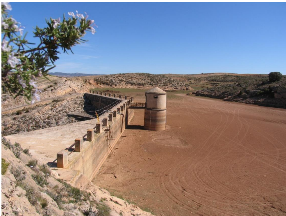
Figura 1 Estado original de la presa de Almansa antes del dragado
