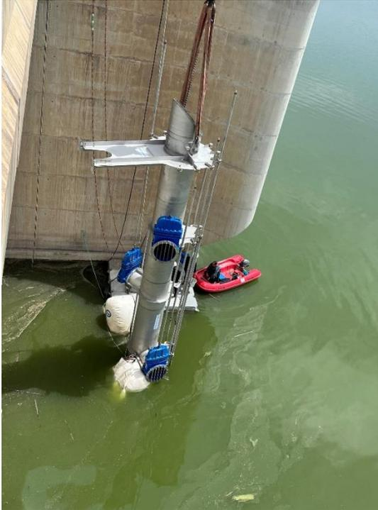
**(b) Parte superior de la Torre Multitoma donde se alojan los motores que accionan las barras de transmisión que aperturan las válvulas.**
