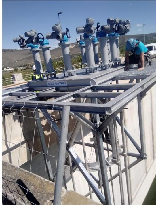
Los motores se actúan mediante un cuadro situado dentro de una caseta hecha ad hoc para proteger los motores. Dicho cuadro se energizó con una línea desde las casetas de operación de las ataguías de los desagües de fondo situada a 80 metros de la caseta de la Torre Multitoma, ver figura 10 (b) y 11.
