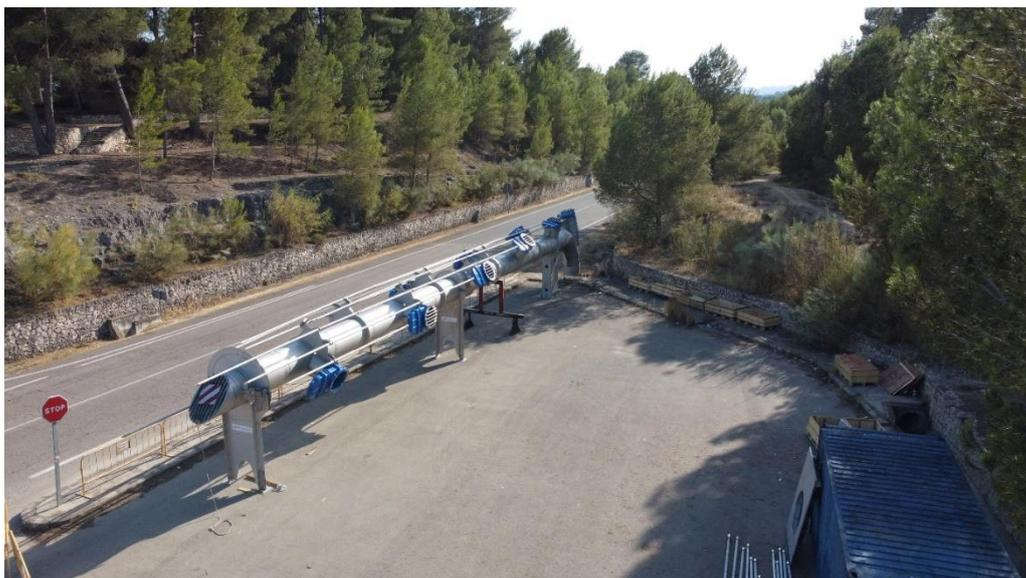
Se traslada la Torre Multitoma a su punto de instalación mediante batea extensible y cabeza tractora. Ver figura 7.
