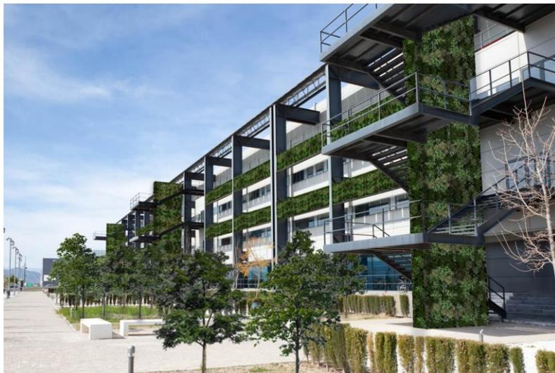
En la Figura 7 se muestra una vista aérea del complejo, en ella se ha implementado fachada y cubierta vegetal integrada con las placas solares, en la fachada se han reemplazado las placas solares por fachadas vegetales ya que esa zona de PV puede ser trasladadas a otras zonas de los alrededores del complejo.
