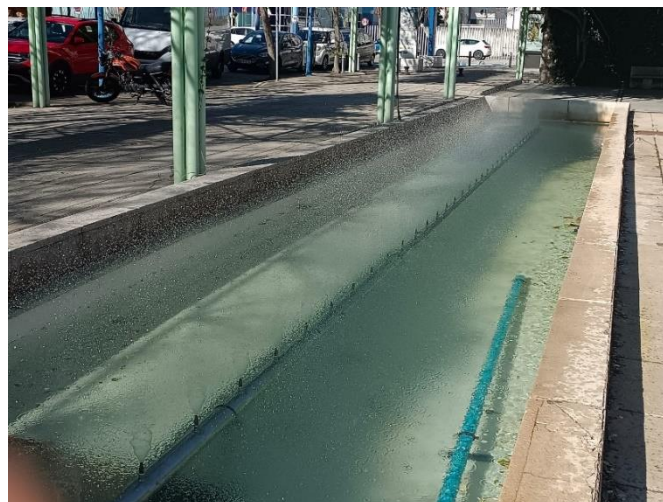
Figura 3. Fotografía del estanque de agua localizado en Cartuja Qanat.
