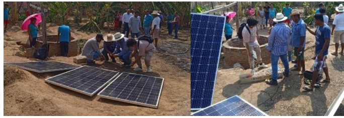
Figura 7. Instalación de un SFVA de bombeo en una colonia de la periferia de la ciudad de Acapulco, después del paso del huracán Otis
