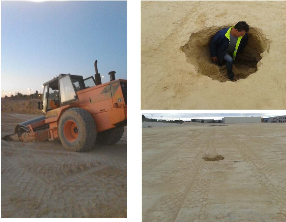
Figura 3: Problemática durante compactación Nov. 2015. Fuente: Elaboración Propia
