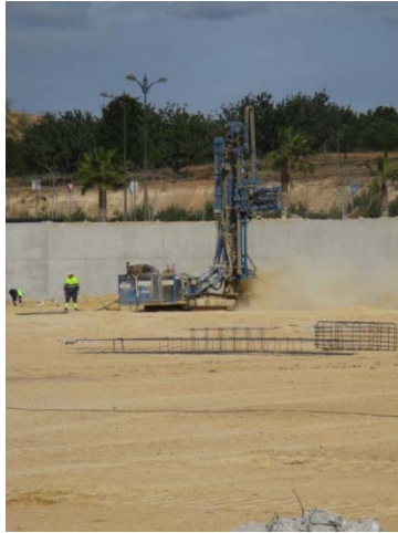
Figura 9: Ejecución de la cimentación. Fuente: Elaboración propia
