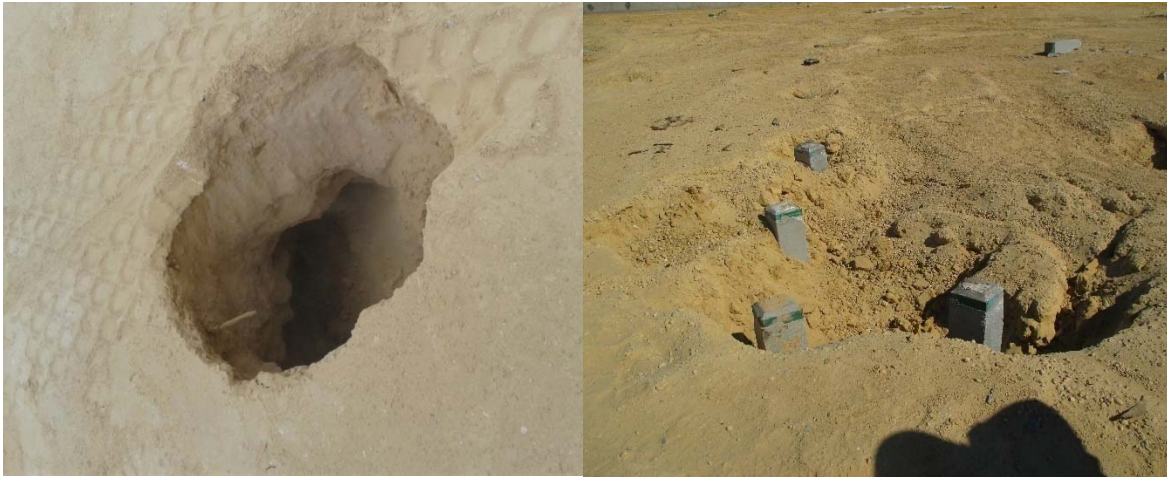
Figura 7: Colapsos del terreno durante cimentación. Fuente: Elaboración propia
