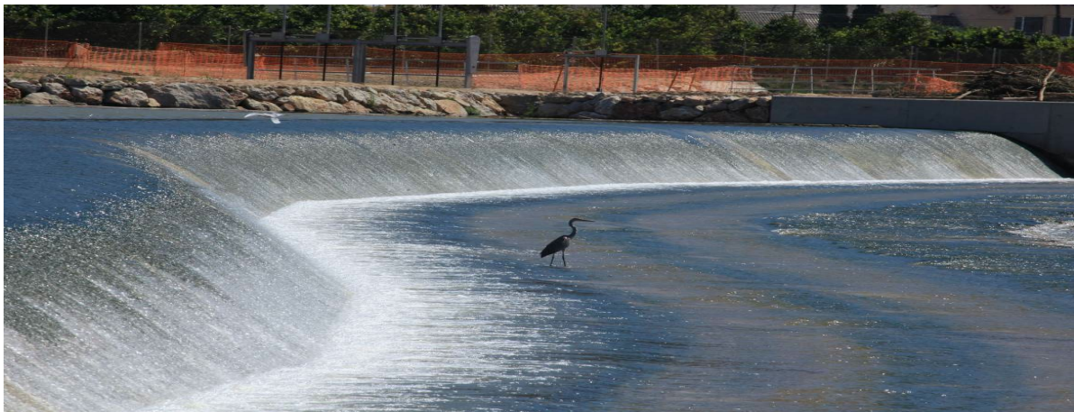
Figura 8 Vista definitiva reconstrucción azud de la Marquesa.
