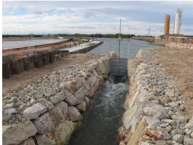
Figura 7 Vista de la escalera de peces realizada escollera
