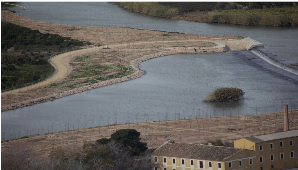
Figura 6 Vista de las plantaciones y escollera realizadas
