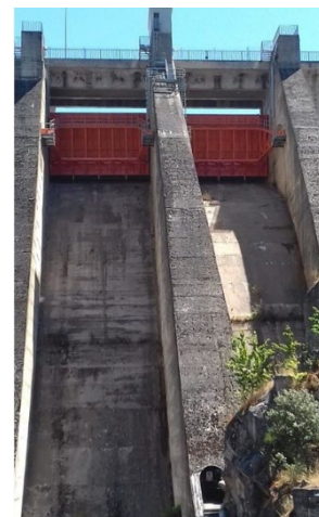
Ilustración 14 Estado final de las compuertas desde aguas abajo
