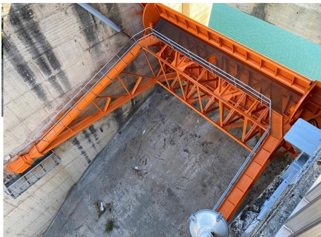
Ilustración 13 Estado final de las compuertas desde coronación.
