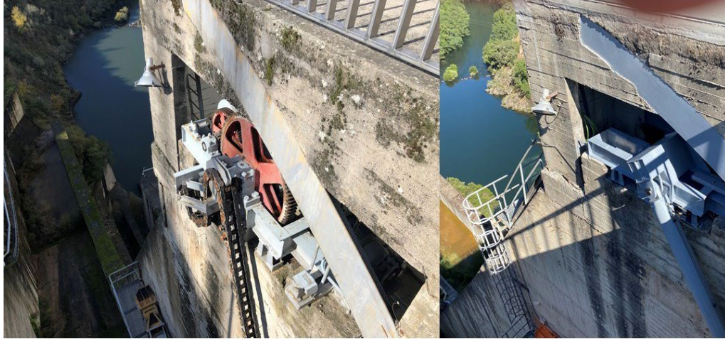
Ilustración 3 Soporte del cilindro antes de la actuación (cadena Galle), foto izquierda, y después de la actuación con cilindro oleohidráulico. (foto derecha)
