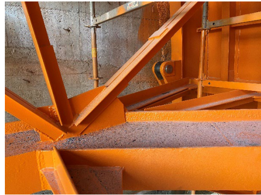
Ilustración 8 Mismo nudo reparado, chorreado, imprimado y pintado
