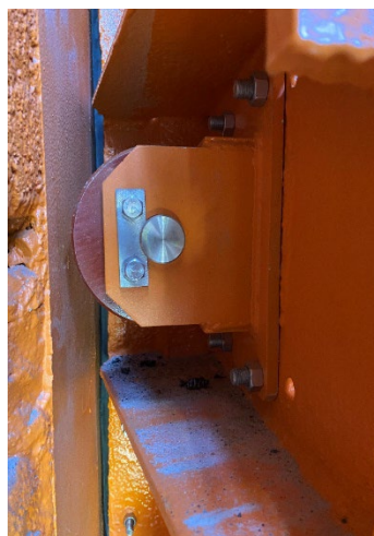
Ilustración 10 Detalle del sistema de guiado
