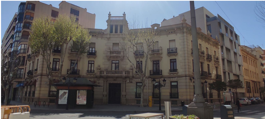
Figura 3: Fotografía del edificio de Amalia Jiménez de Córdoba en la plaza de Gabriel Lodares. Fuente: Elaboración propia.
