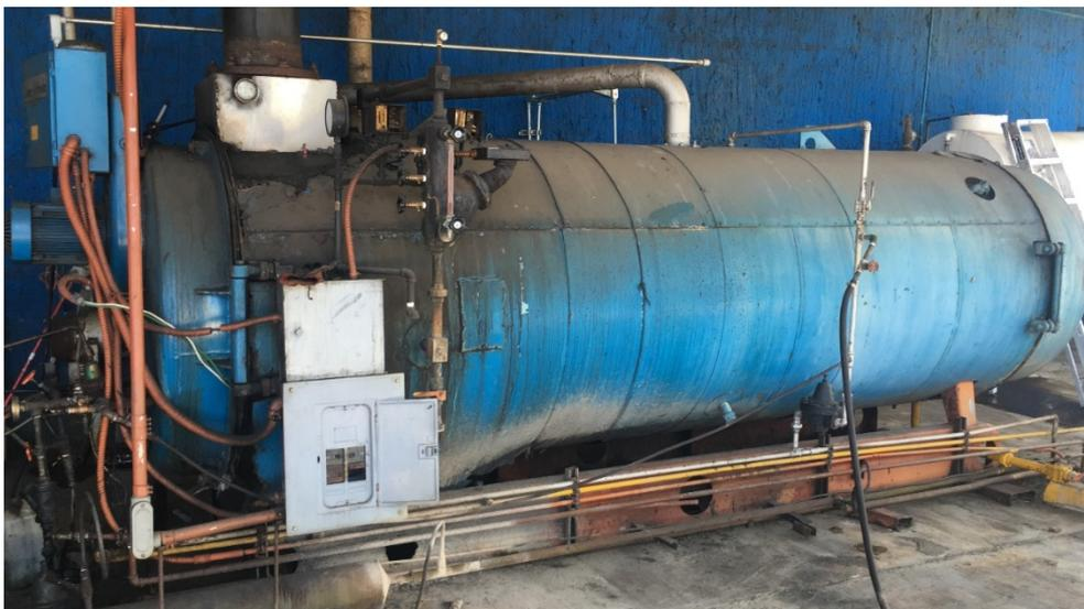
La eficiencia de la caldera se determinó mediante el **método indirecto o de las pérdidas**, ya que no hay medidores de agua de alimentación o de vapor, por lo que el **método directo** no se utilizó. La eficiencia por el método indirecto se calcula según
