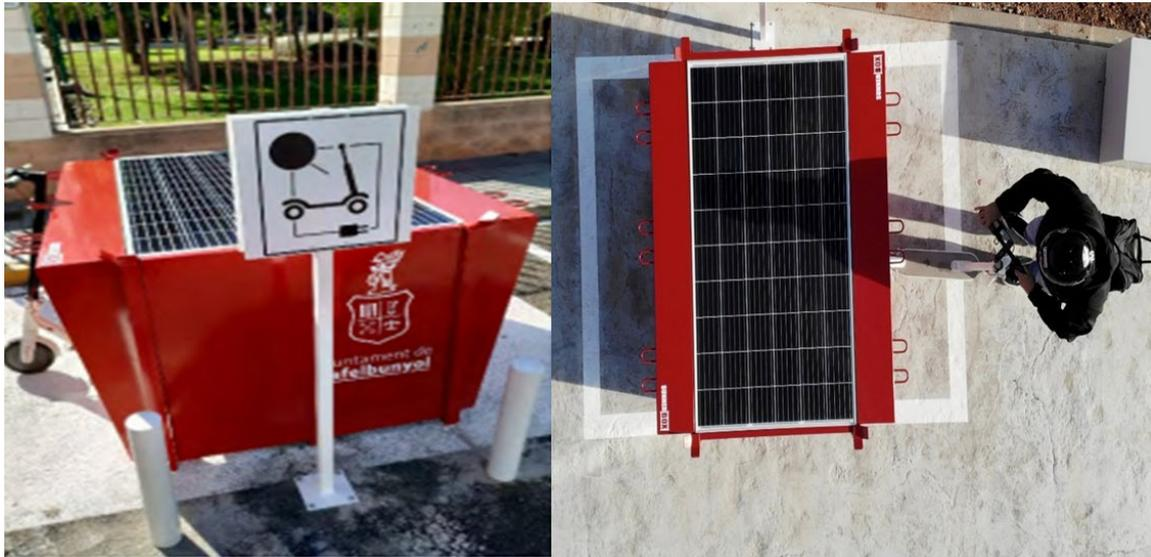
La unidad de recarga está concebida como un sistema fotovoltaico autónomo que incluye los siguientes componentes montados en una plataforma móvil: módulo fotovoltaico; Regulador de carga PWM; Batería de ácido sólido; y un inversor siendo el fabricante de la unidad la empresa SunnerBox, S.L.
