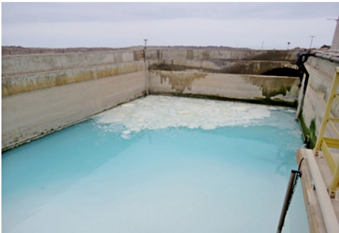
Figura 1: Depósito de AR, planta de ósmosis inversa de Aguas CAP
