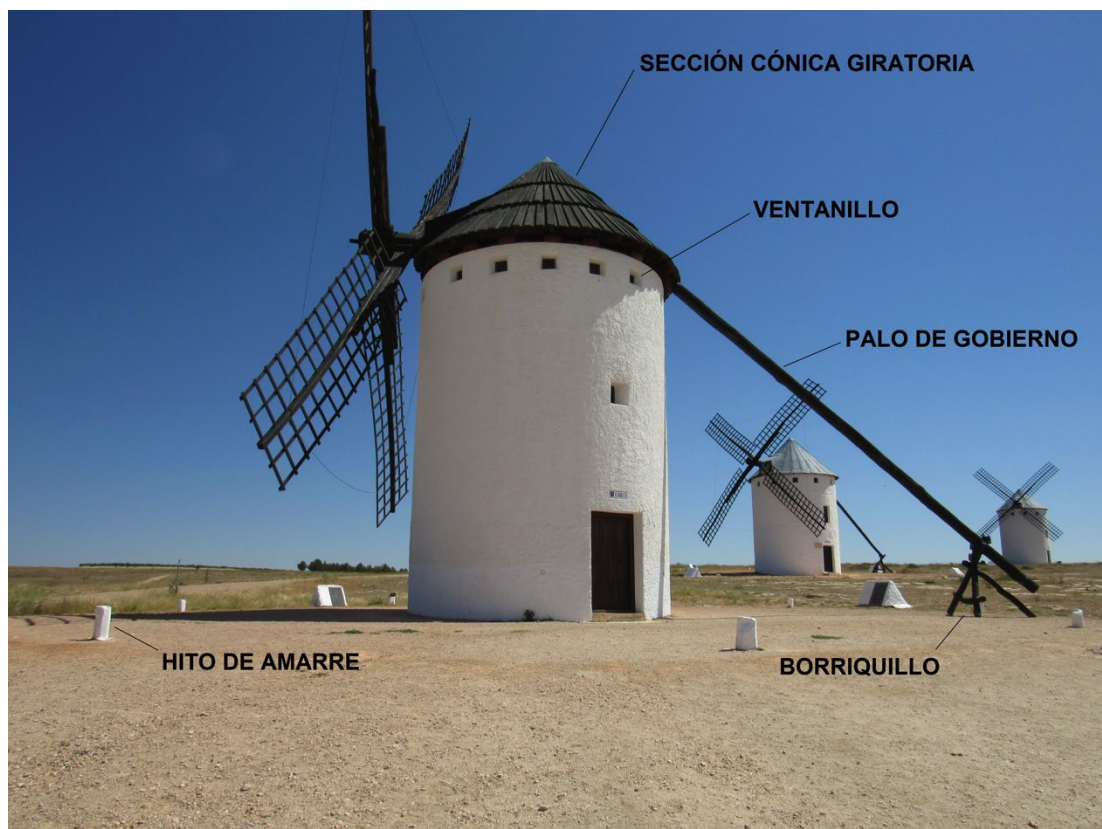
Figura 5. Elementos relacionados con la maniobra de orientación a barlovento
