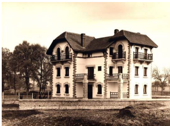
Fot. 3: Casa Almacén de Vitoria
