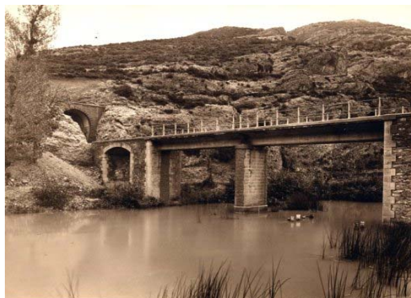
Fot. 4: Puente y túnel de Zubielqui
