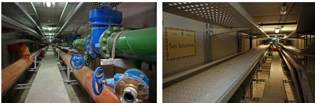
Figura 5. Imágenes interiores de la galería de servicio del Casco Antiguo de Pamplona.
