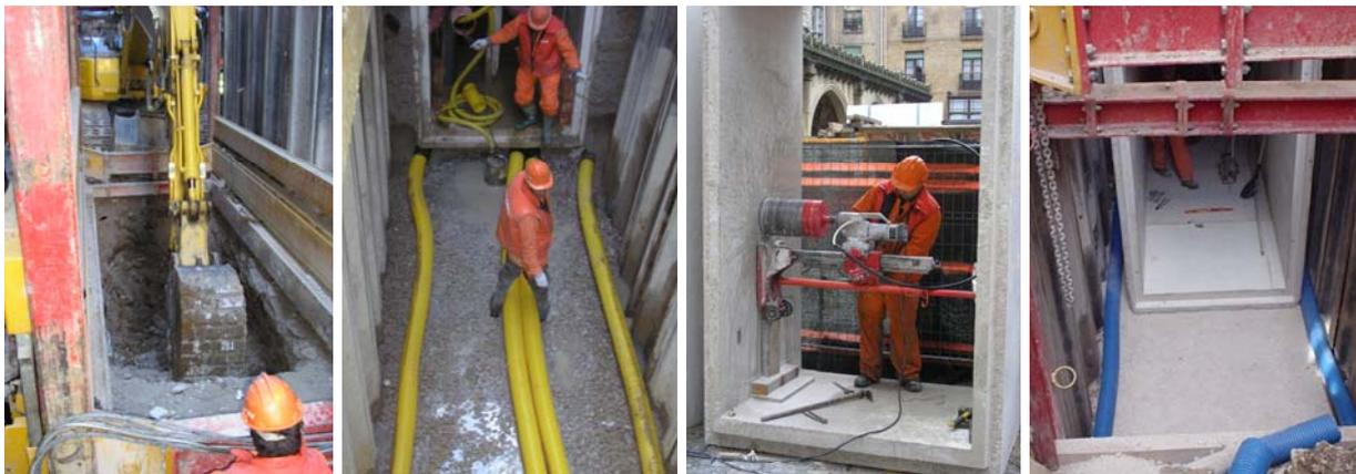
Figura 5. Proceso constructivo de la galería de servicio [imágenes cedidas por Arian Construcción].
