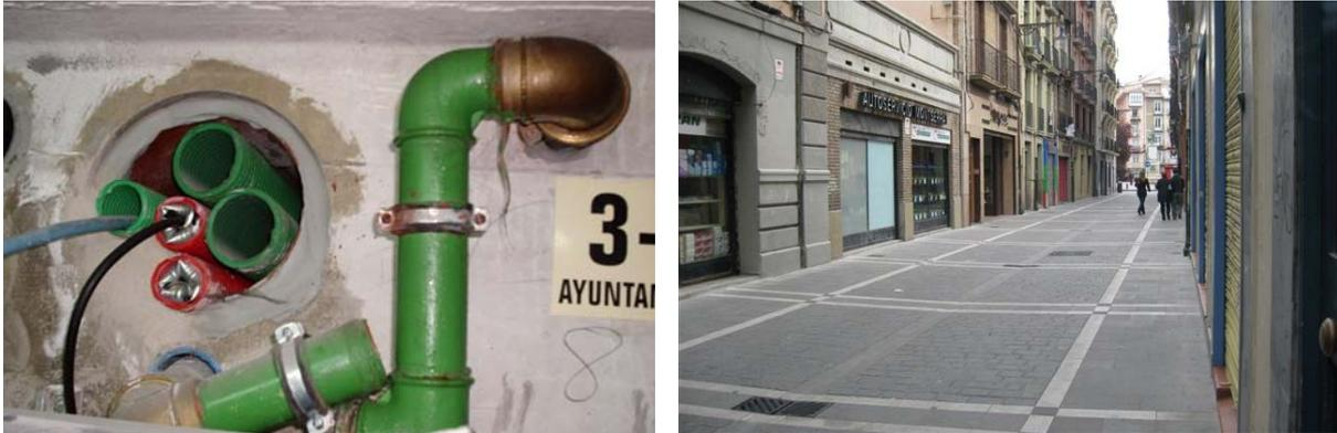
Figura 7. Salida de acometidas de galería a portal de viviendas e imagen final calle reurbanizada.
