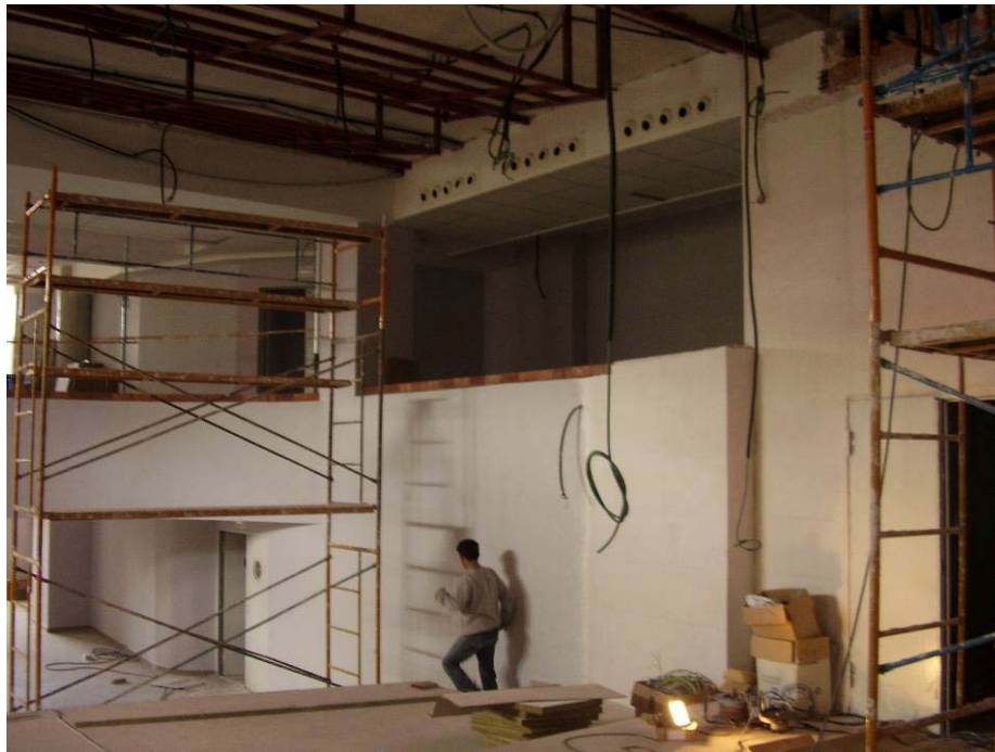
Figura 3 Sala de audición y ensayo en Ejecución
