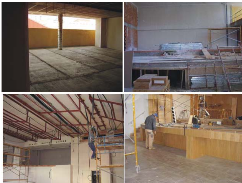
Figura 4 Ejecución de la Obra
