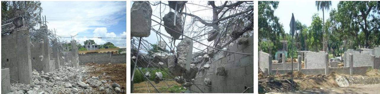
Figura 4. Demolición losa de hormigón por incumplimiento de resistencia
