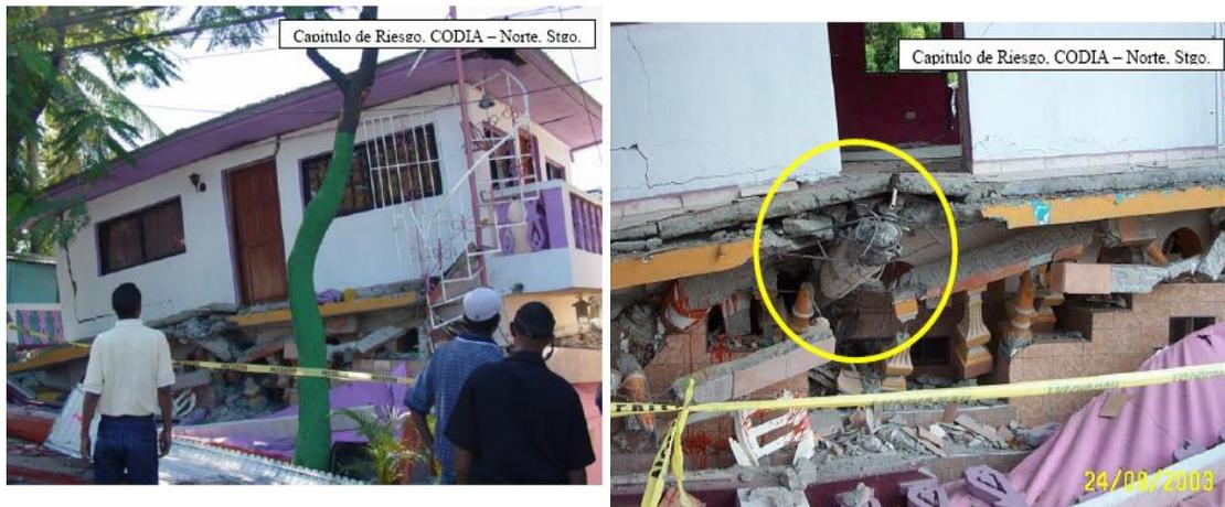
Figura 3. a) Colapso de 1er nivel de vivienda, construcción informal. b) Inadecuada conformación de los elementos estructurales
