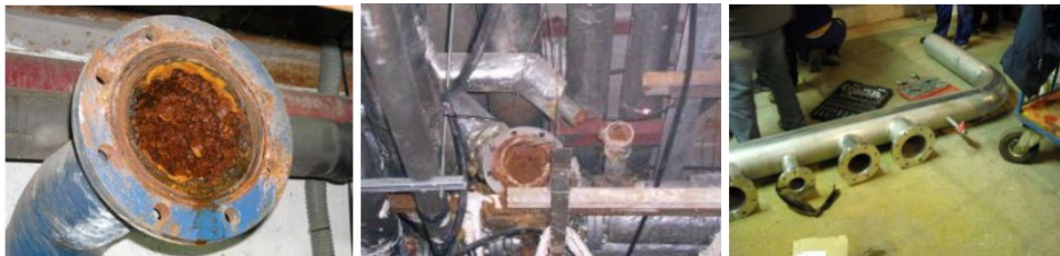
Figura 1: Interior de las tuberías viejas (izquierda y centro) y nuevo colector (derecha)
