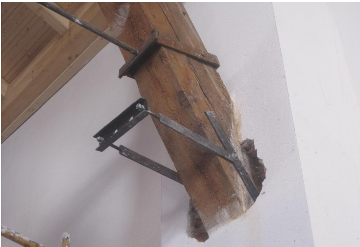
Figura 6. Ejecución de los nuevos tirantes
