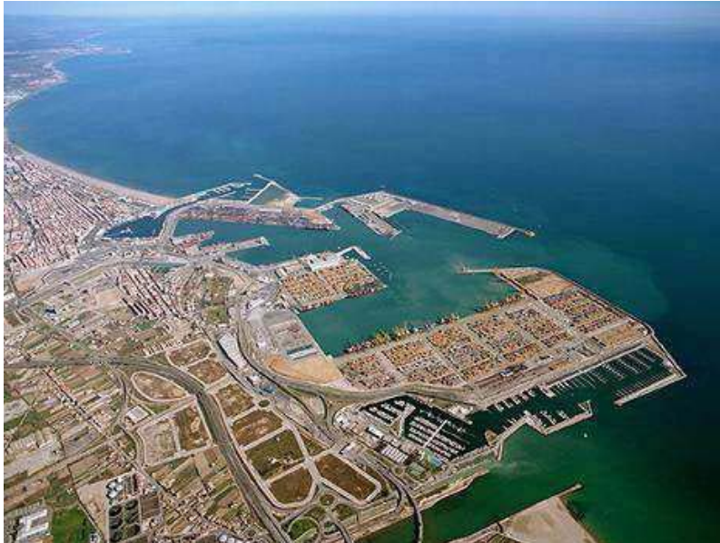
Figura 1: Vista aérea del Puerto de Valencia
