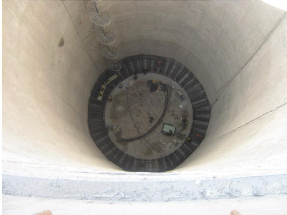
*Fig. 1 Vista en planta de una lumbrera de 40m de profundidad, fuente: propia*
