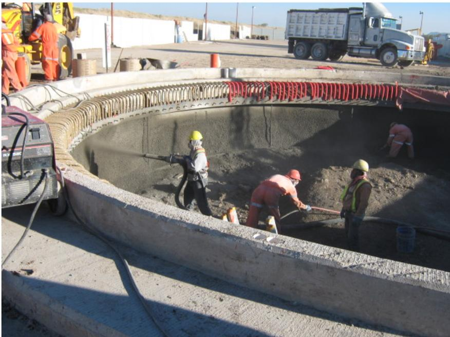
*Fig. 2 Trabajadores lanzando concreto, fuente: propia*
