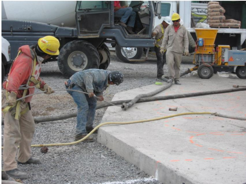
*Fig. 5 Personal tratando de retirar el material atrapado en el interior de la tubería, de una forma precaria, fuente: propia*
