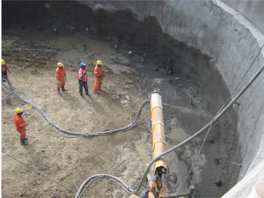
Fig. 4 Lanzado de concreto (con mezcla húmeda) mediante equipo robotizado "robojet",
