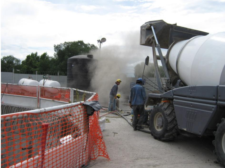
*Fig. 6 Momento en el que sale proyectado el material que obstruye la tubería, logrado a base de incrementar la presión de aire comprimido (después de varios intentos fallidos), fuente: propia.*
