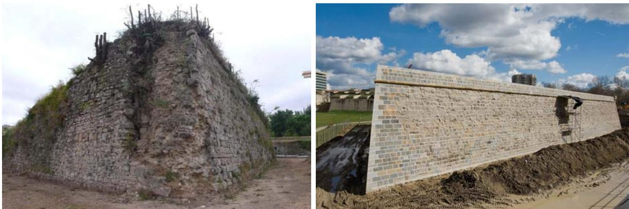
En todas estas actuaciones los procesos seguidos han sido muy similares: numeración y retirada de aquellos sillares con riesgo de desprendimiento, eliminación de la vegetación existente y aplicación de biocidas, reposición de sillares, limpieza de los lienzos mediante cepillado y rejuntado con cal hidráulica.
