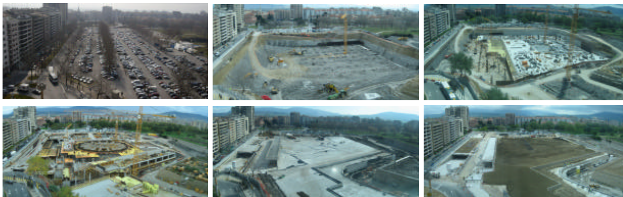
Figura 10. Evolución de la ejecución de las obras.
