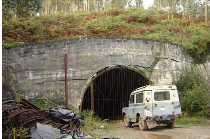
Figura 4. Boca de la mina de carbón
