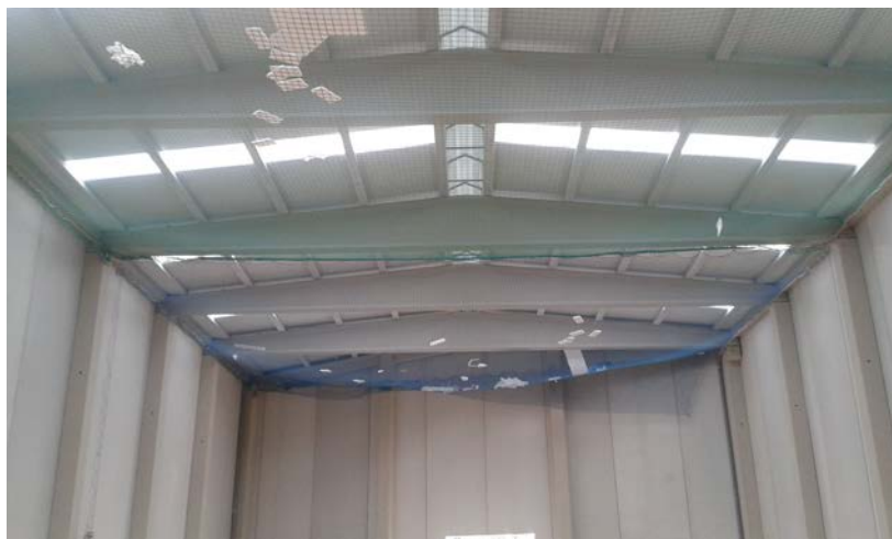
Figura 9: Vista interior conjunto nave prefabricada en construcción (Nave Envases)
