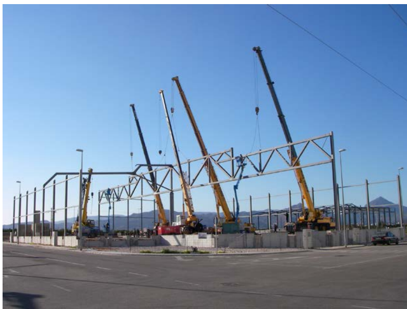
Figura 8: Montaje de la celosía longitudinal (Nave1)
