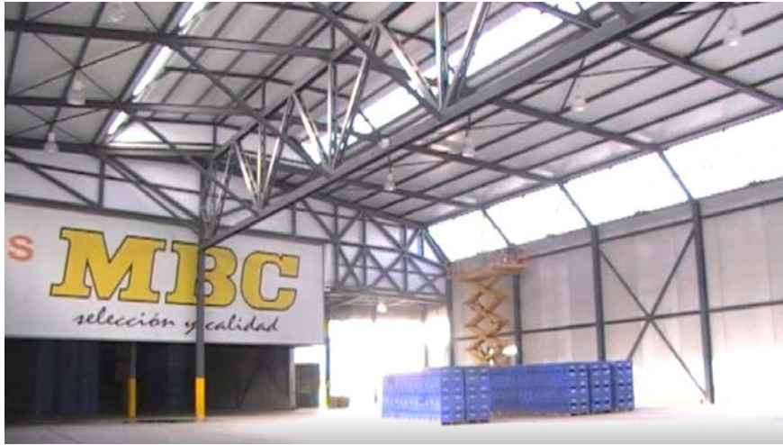
Figura 11: Vista interior en construcción de la fachada oeste con muelles de recepción
