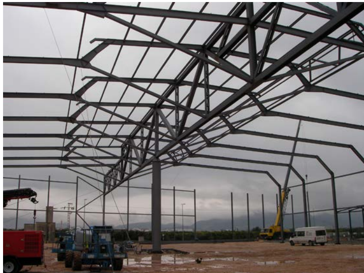
Figura 6: Vista general interior (Nave1) desde fachada este
