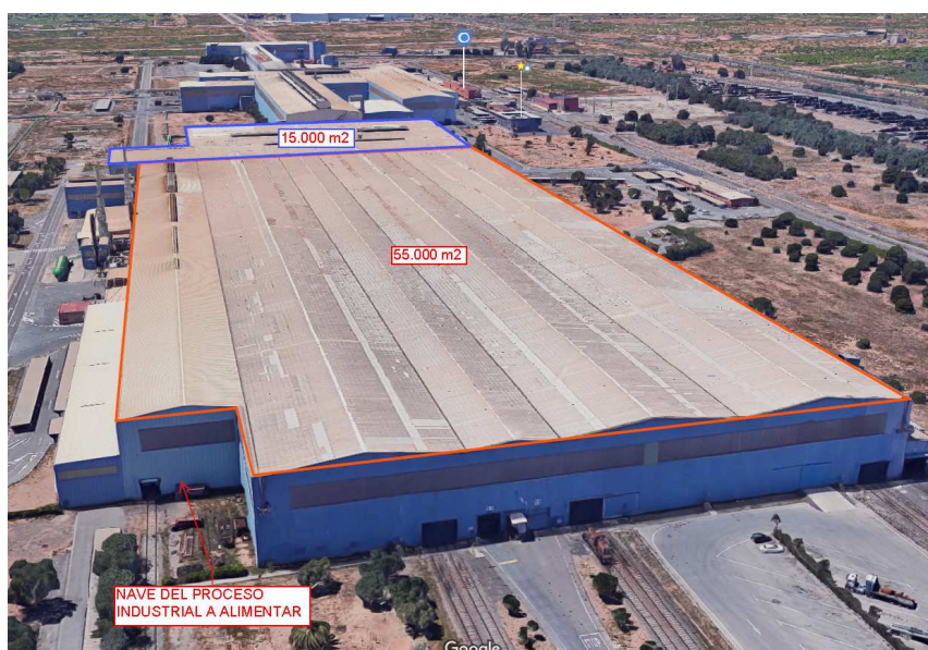
Figura 7: Área principal aprovechable para posible instalación fotovoltaica sobre cubiertas
