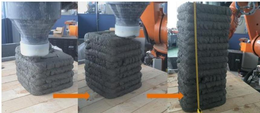
Cabe destacar que el método de impresión comenzó realizando la parte interna o núcleo del pilar, para luego realizar la impresión de su periferia hasta completar las dimensiones de este.
