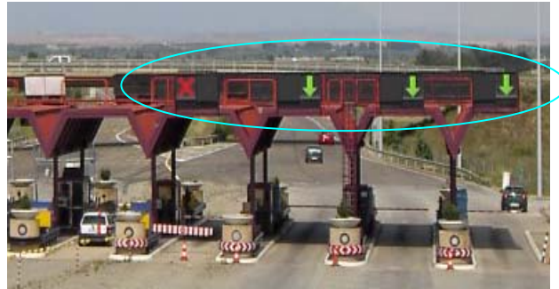
Figura 3. Ejemplo de ubicación de los semáforos en la zona de las vías de un peaje
