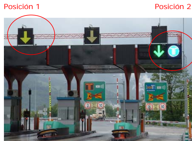
Figura 4. Ejemplo de colocación de los semáforos encima de la marquesina (Posición 1) y encastrado en la misma (Posición 2), en la misma zona de salida de un peaje
