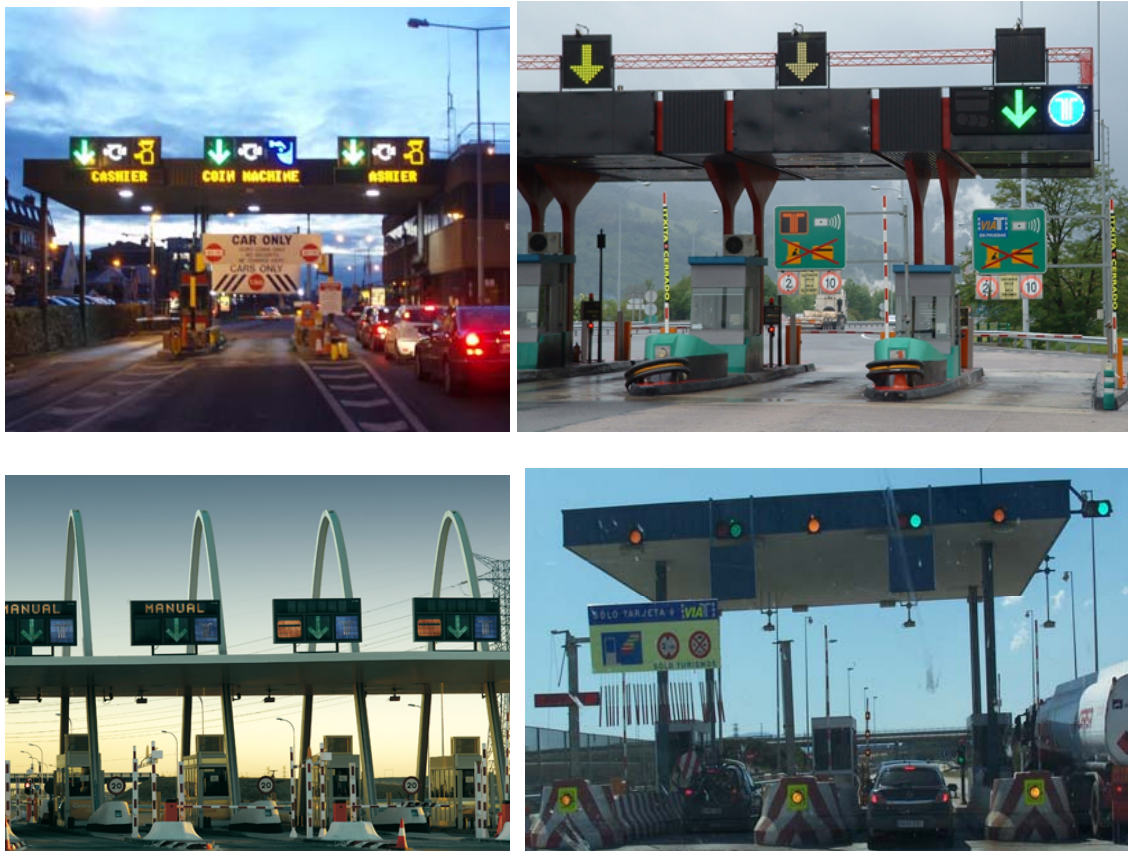
Figura 9. Ejemplos de autopistas nacionales e internacionales (Irlanda) con diferentes tipos de semáforos y pictogramas
