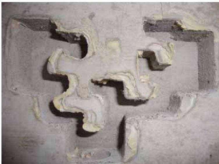
La simbiosis entre ambas tecnologías del hormigón es correcta garantizado unos acabados estéticos óptimos en los que no se aprecia la aparición de ninguna de las fibras metálicas que pueda alterar la imagen del conjunto.
