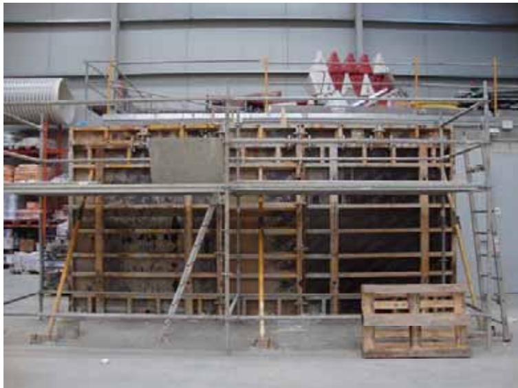
Mas importante es si cabe, la orientación que impone el flujo del hormigón en su recorrido dentro del encofrado, paralela a la dirección longitudinal del muro. El movimiento de la masa y el efecto pared de los encofrados obligan a las fibras a posicionarse paralelas a la dirección en la que se producen los esfuerzos de tracción principales de la estructura.
