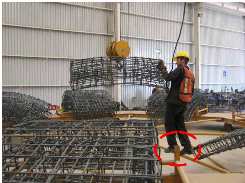
*Fig. 3: trabajador con calzado antiderrapante y sobre tubo de acero redondo*
