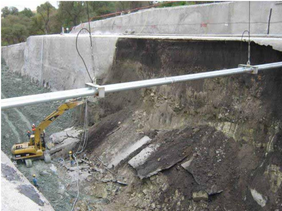
*Fig. 5. Derrumbe en canal de conducción, aún con la estabilización de concreto lanzado.*
