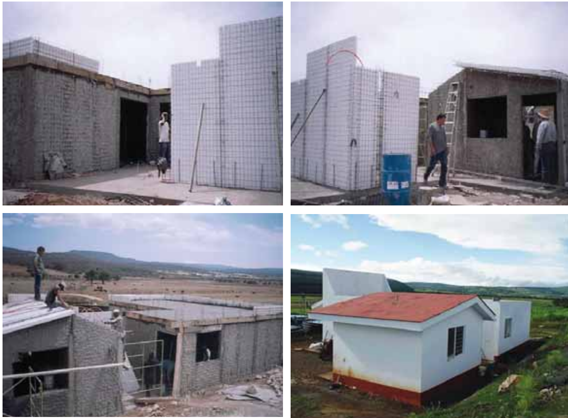
Figura 5. Vistas progresivas de edificación con panel estructural RYMSA
