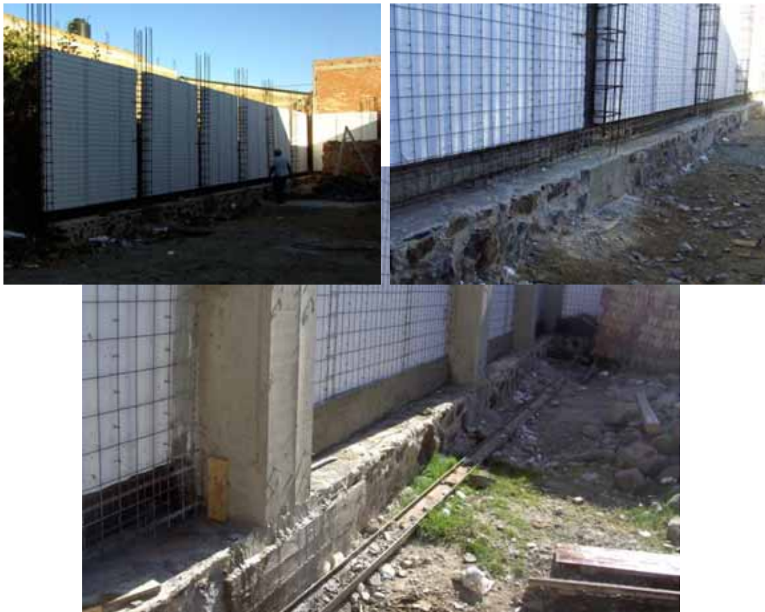
Figura 8. Sobrecimiento o Dala de Desplante, sobre mampostería. Mismo tratamiento en caso de requerir columnas o castillos. Ver en figura tratamiento diferente en caso de columnas de dimensiones especiales.
