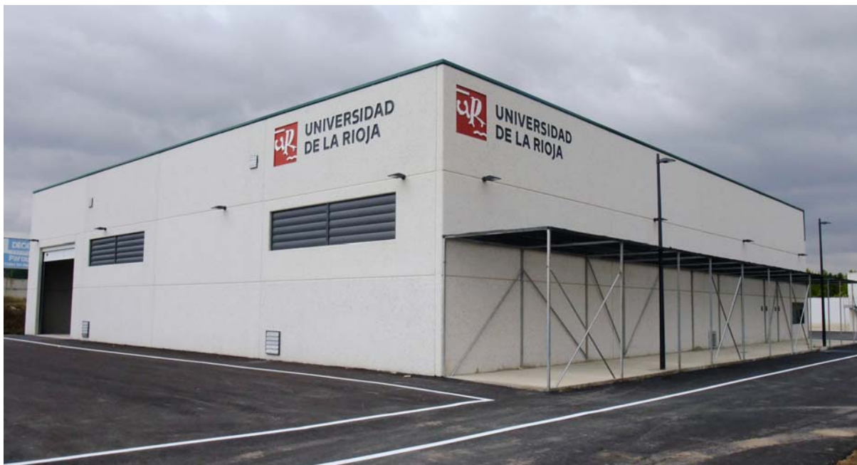
Figura 9. Aspecto final de la nave terminada. Se aprecia en el exterior el umbráculo.
