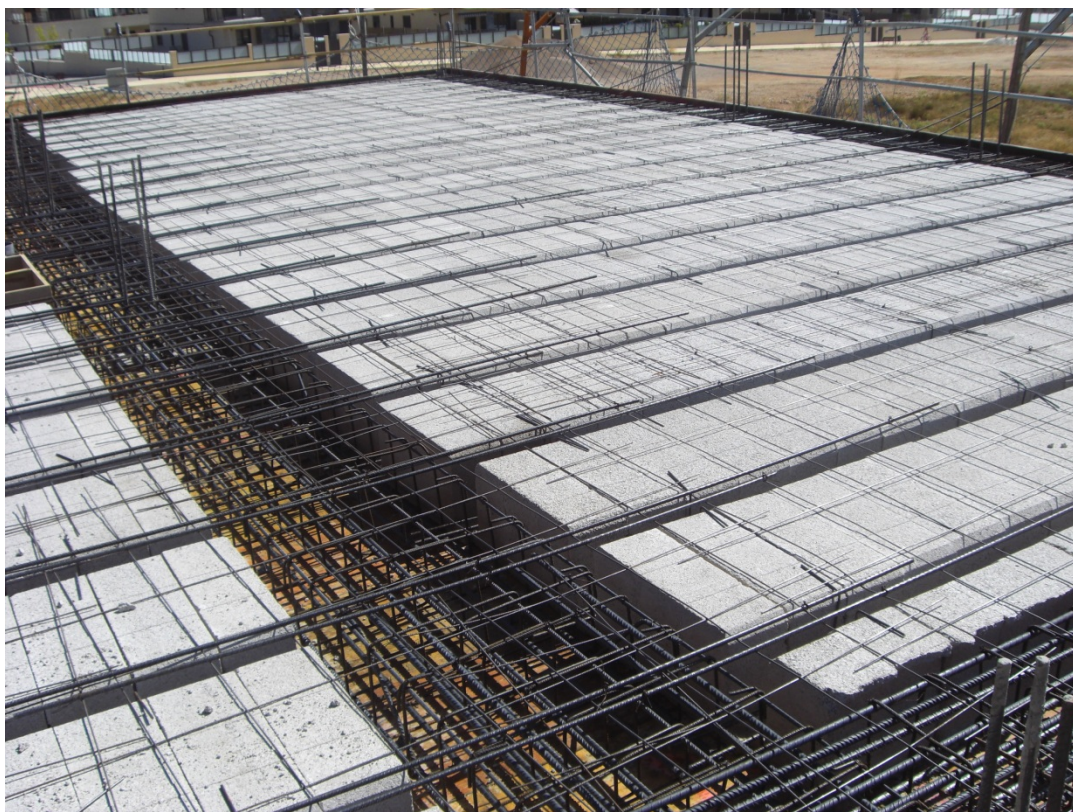
Figura 1: Forjado unidireccional
