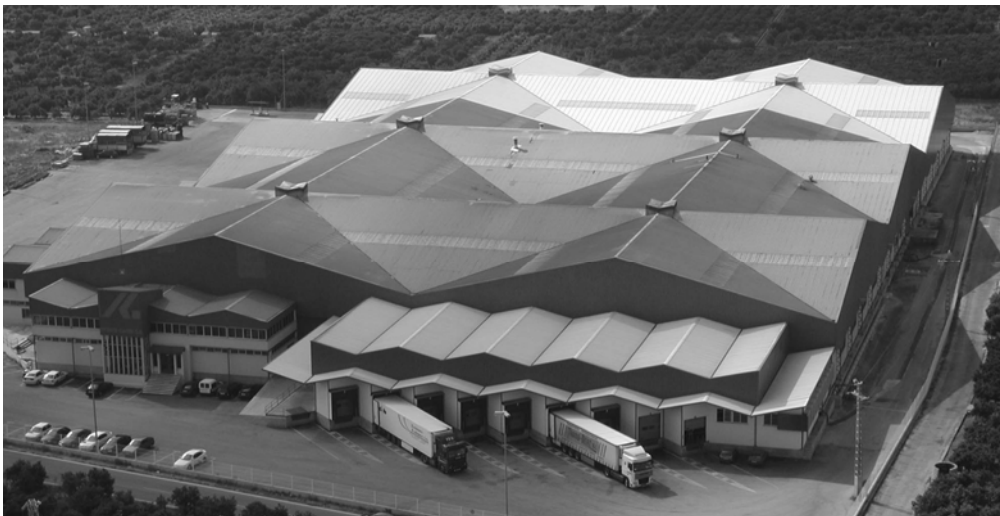
Figura 3: Vista de conjunto del edificio original
