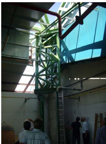
Figura 6: Pilar original para salvar la interferencia con un algebe
