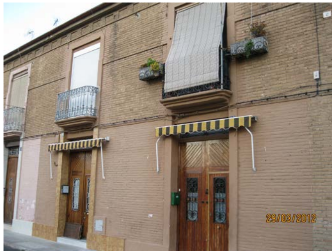
Figura 6. Distintas protecciones solares ubicadas en la fachada oeste.
