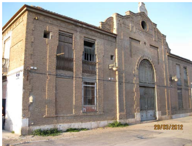
Figura 2. Fachada sur del edificio.
