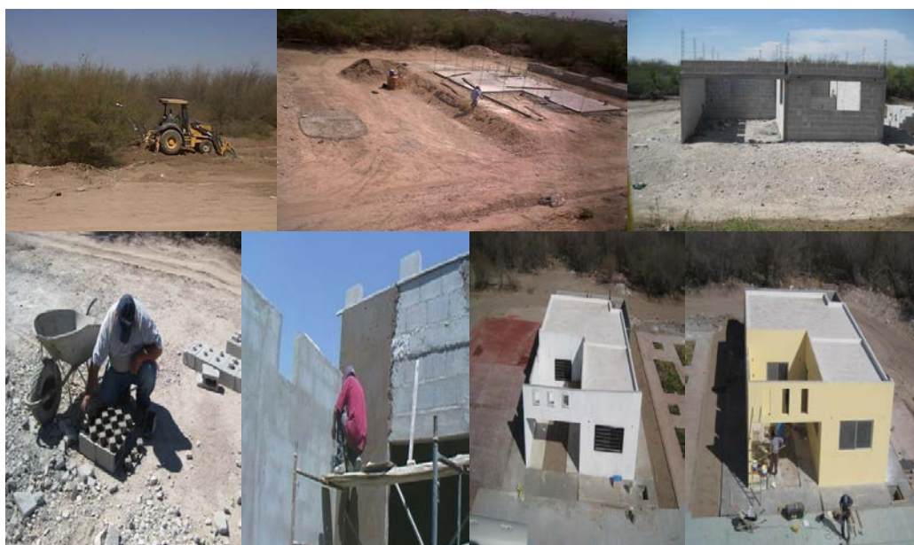
Figura 1: Fases de Construcción de las Viviendas
