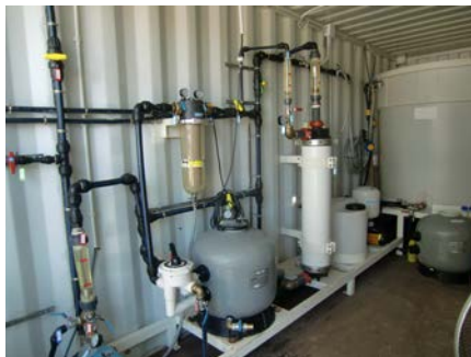
Figura 2: Imagen de la unidad potabilizadora instalada (interior del contenedor marítimo) en el Hospital de Ressano Garcia (Mozambique). Febrero de 2010
