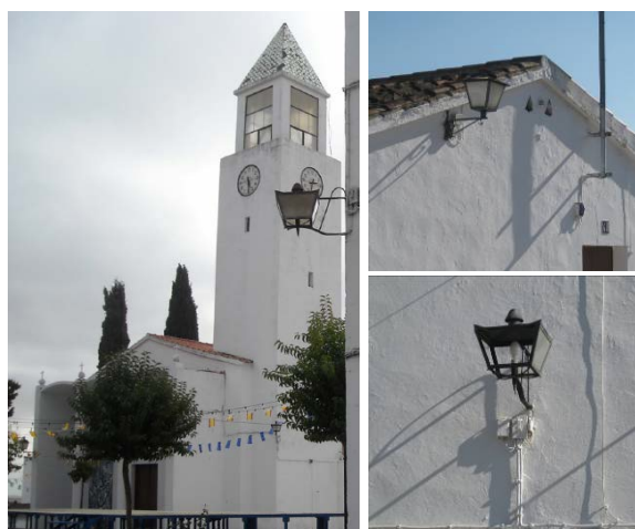
Figura 1: Luminaria tipo instalación alumbrado público inicial.
