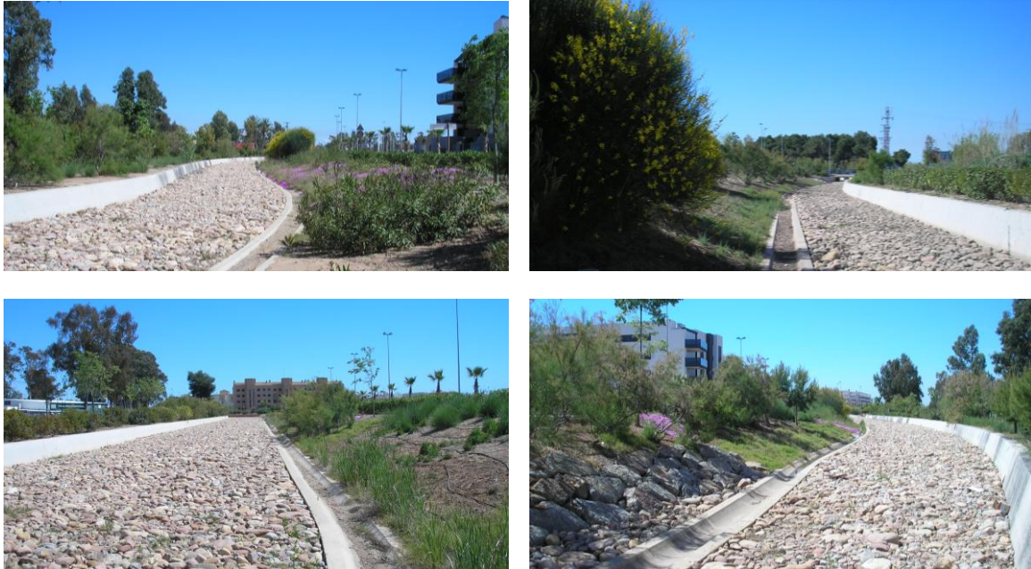
Figura 7: Canal Perimetral con Solera de Bolos y Cajero Vegetado
