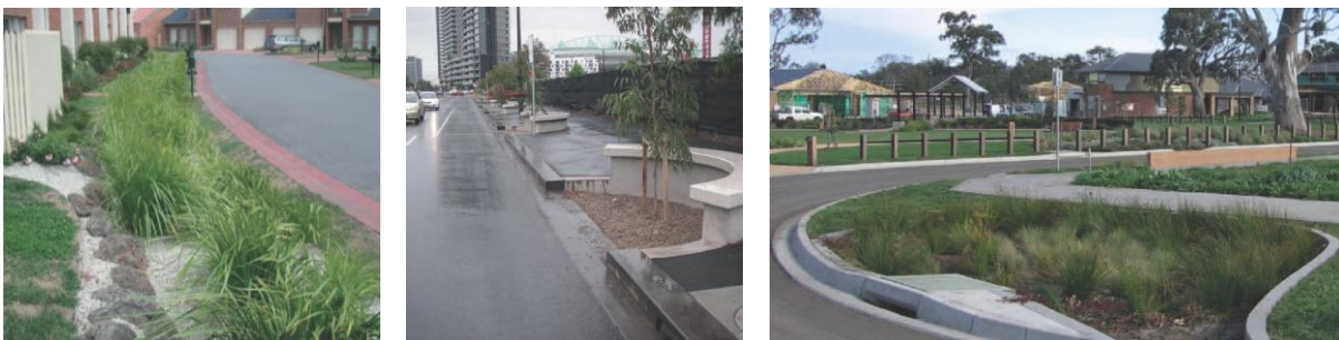
Figura 4: Ejemplos de Sistemas de Biorretención: cuneta vegetada con zanja filtrante; alcorque con pozo filtrante; parterre con lecho filtrante
