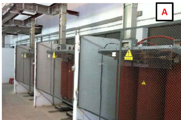
Figura 3:A) Detalle sistema de canalización electrificada y transformadores secos .B) Detalle de sala técnica térmica de calderas, diseñada para las correctas funciones de mantenimiento. Fuente: Elaboración propia.
