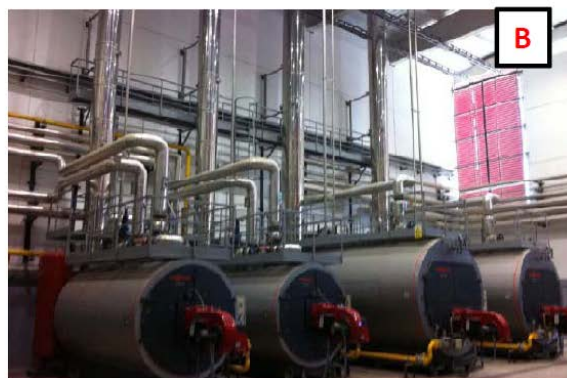
Figura 3:A) Detalle sistema de canalización electrificada y transformadores secos .B) Detalle de sala técnica térmica de calderas, diseñada para las correctas funciones de mantenimiento. Fuente: Elaboración propia.
