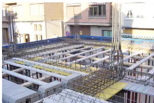
Figura 3: Imagen de construcción auxiliar
