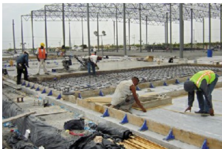
Figura 1: Construcción Tradicional de una Nave Industrial.
